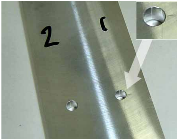
Visible Fatigue Crack
